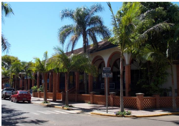
Figura 11: Vista das fachadas térreas.
