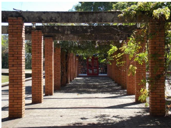
Figura 9: Vista do pergolado.
