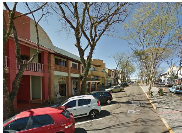
Figura 12: Vista das fachadas térreas.
