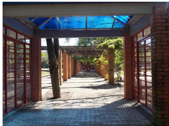
Figura 10: Vista do pergolado.
