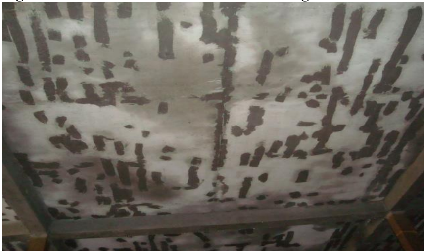
Figura 7 – Cobrimento da armadura com argamassa
