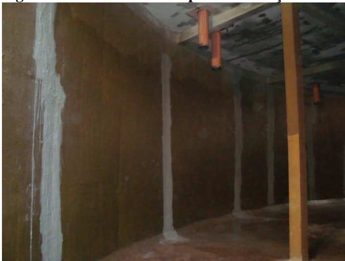
Figura 8 – Fechamento e impermeabilização das trincas
