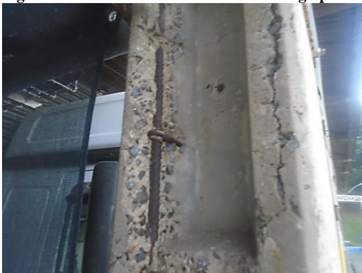
Figura 3 – Coluna de concreto armado no galpão de recepção
