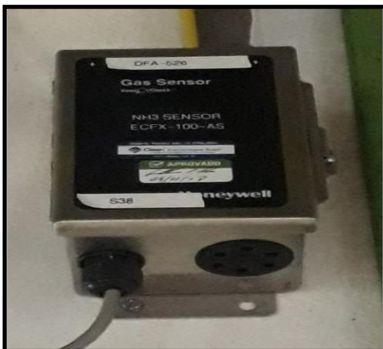
Figura 10 – Sensor detector de amônia.
