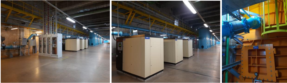
Figura 4 – Sistema de rebaixamento das Unidades Geradoras.
