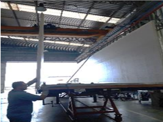
Foto C: Posicionando painel lateral
