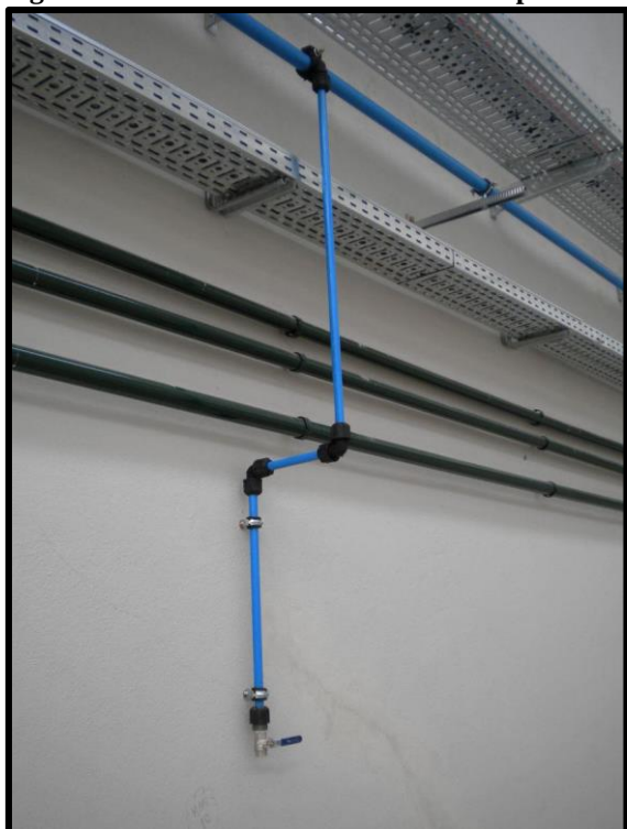
Figura 7 - Ponto de Consumo de Ar Comprimido
