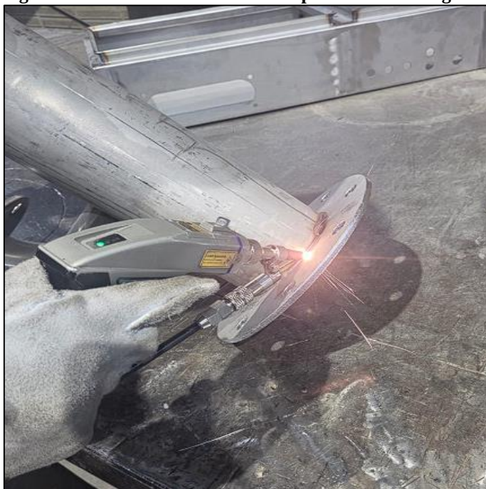
Figura 4 – Profissional executando o processo de soldagem a laser
