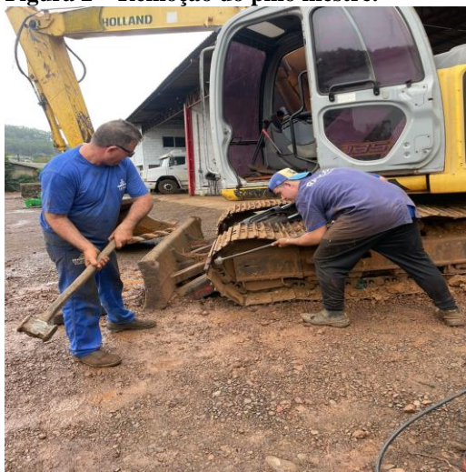
Figura 2 – Remoção do pino mestre.
