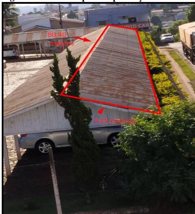
Figura 2 – Área útil para implantação do Sistema Fotovoltaico
