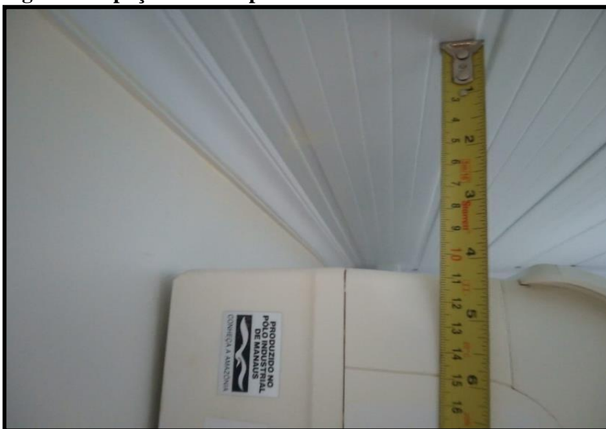
Figura 4- espaço entre evaporadora e o teto
