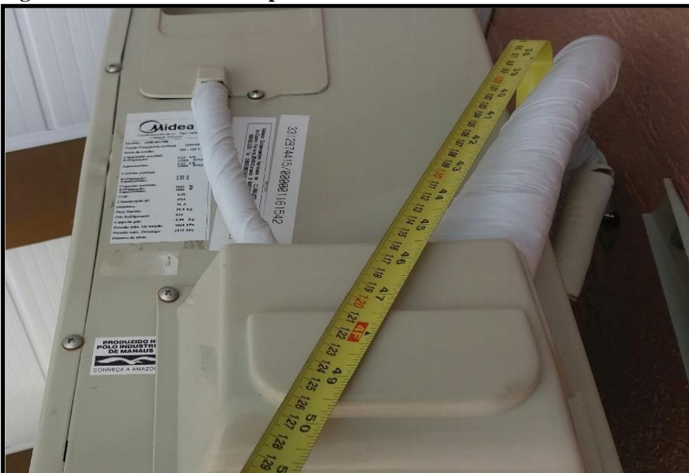
Figura 5- distância entre evaporadora e condensadora
