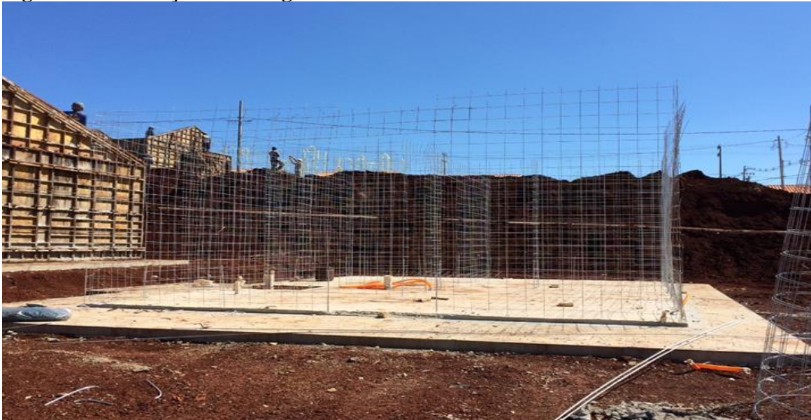
Figura 04 - Armação em tela galvanizada
