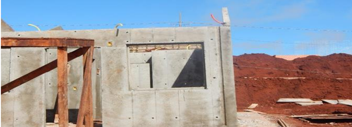
Figura 03 - Estrutura, após a desforma
